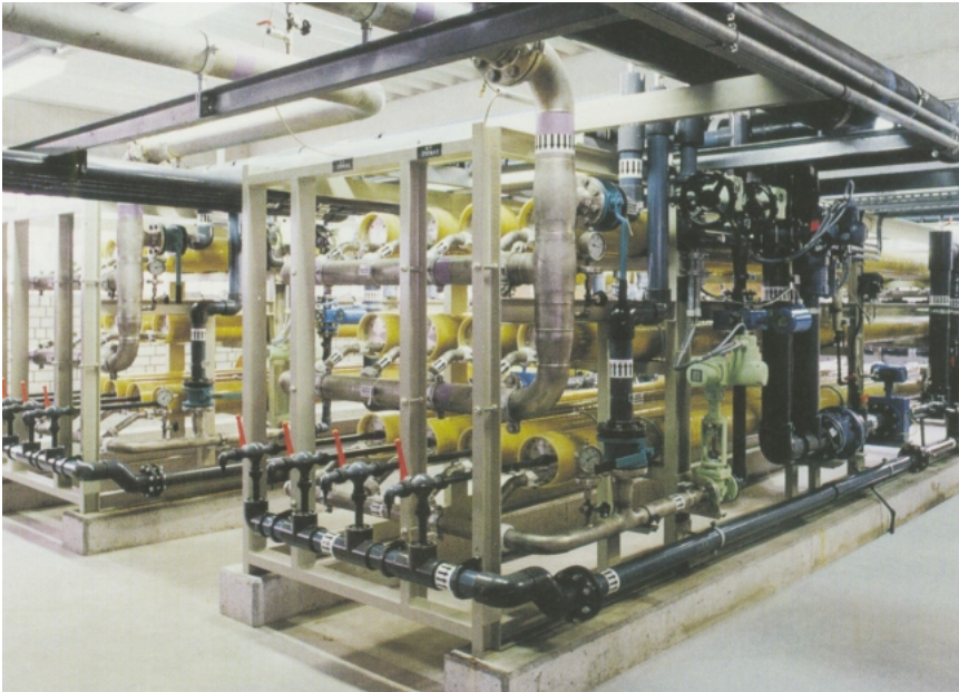
Bild 9: Meerwasserentsalzung mittels Umkehrosmose, gebaut von Preussag Noell Wassertechnik GmbH (Foto: ThyssenKrupp VDM GmbH, Werdohl)
