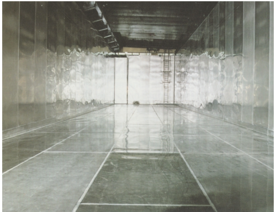
Bild 7: Auskleidung eines Trinkwasser-Hochbehälters mit Edelstahl Rostfrei (Foto: Noell Service und Maschinentechnik GmbH, Würzburg)
