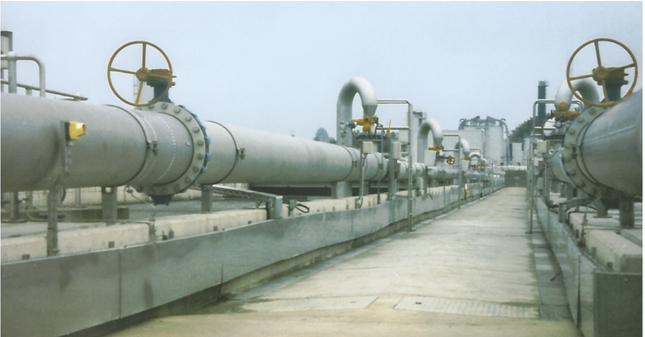
Bild 11: Edelstahl Rostfrei in der Abwasserbehandlung (Foto: H. Butting GmbH & Co. KG, Knesebeck)
