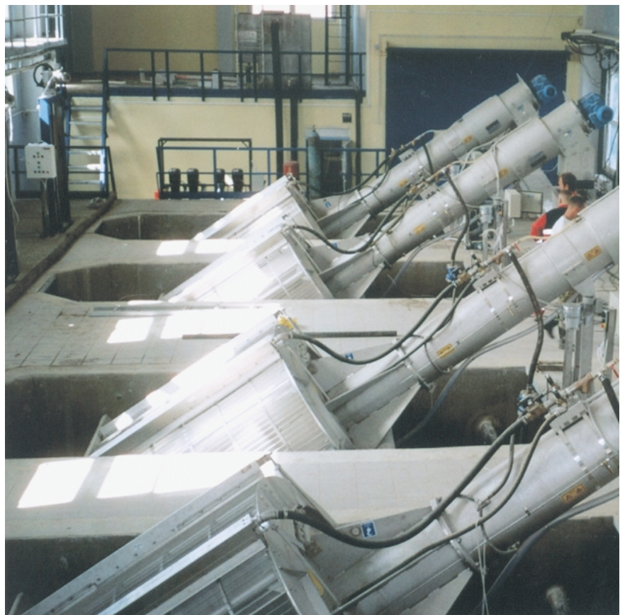
Bild 14: Siebanlagen aus Edelstahl Rostfrei im Zulauf einer Kläranlage (Foto: Hans Huber AG, Berching)
