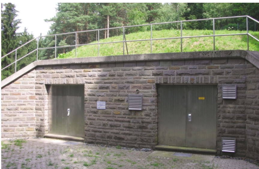
Bild 6: Sicherheitstüren aus Edelstahl Rostfrei für den Objektschutz eines Trinkwasser-Hochbehälters, darüber Geländer aus Edelstahl Rostfrei (Foto: U. Heubner, Werdohl)
